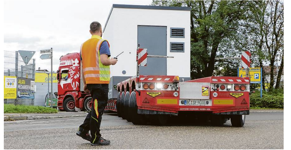
Per Schwerlasttransport wird das kleine Häuschen, in dem künftig das Internet verteilt wird, aus Nürtingen angeliefert.
