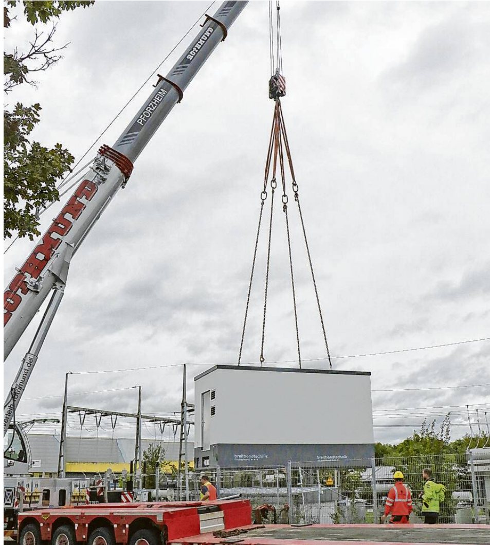
Rund 30 Tonnen wiegt der zentrale Versorgungspunkt für die Mühlacker Breitbandversorgung – da ist Kranarbeit gefragt. Fotos: Steigleder
