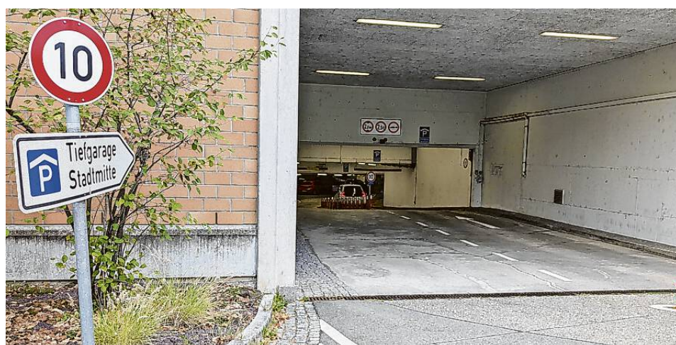
Die baulichen Mängel in der Tiefgarage Stadtmitte/Rathaus sind schon seit rund einem Jahrzehnt bekannt. Doch die grundlegende Sanierung lässt auf sich warten. Jetzt soll sich ein Fachbüro mit den Schäden befassen und einen Sanierungsplan vorlegen. Foto: Archiv
